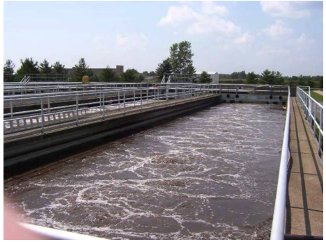
บ่อบำบัดน้ำเสีย
